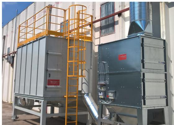
Filter/Adsorbentien mit Aktivkohle werden in der Industrie in Prozessanlagen zur Sanierung von Arbeitsräumen zum Schutz der Luftqualität beispielsweise in folgenden Branchen angewendet:
